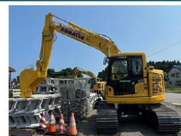
入替後の建設機械
