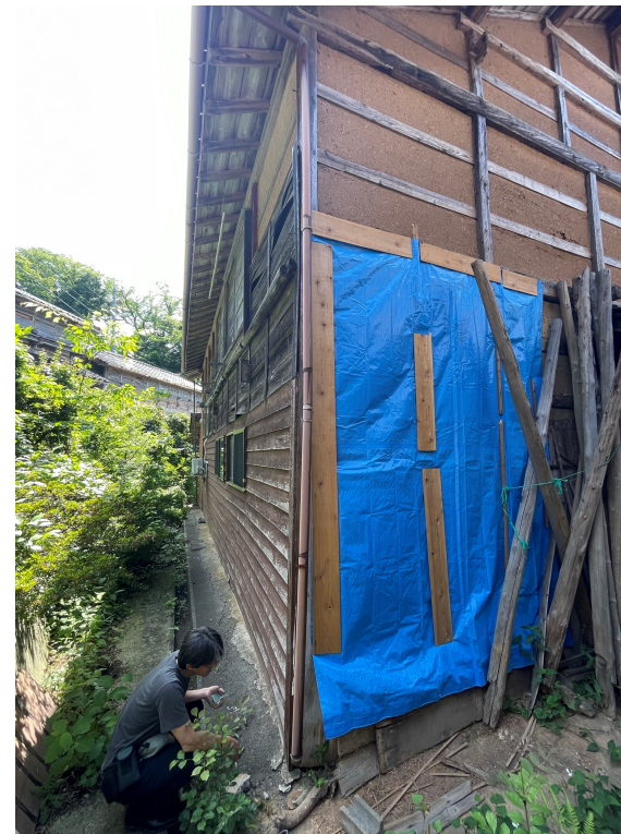
出隅柱移動している
