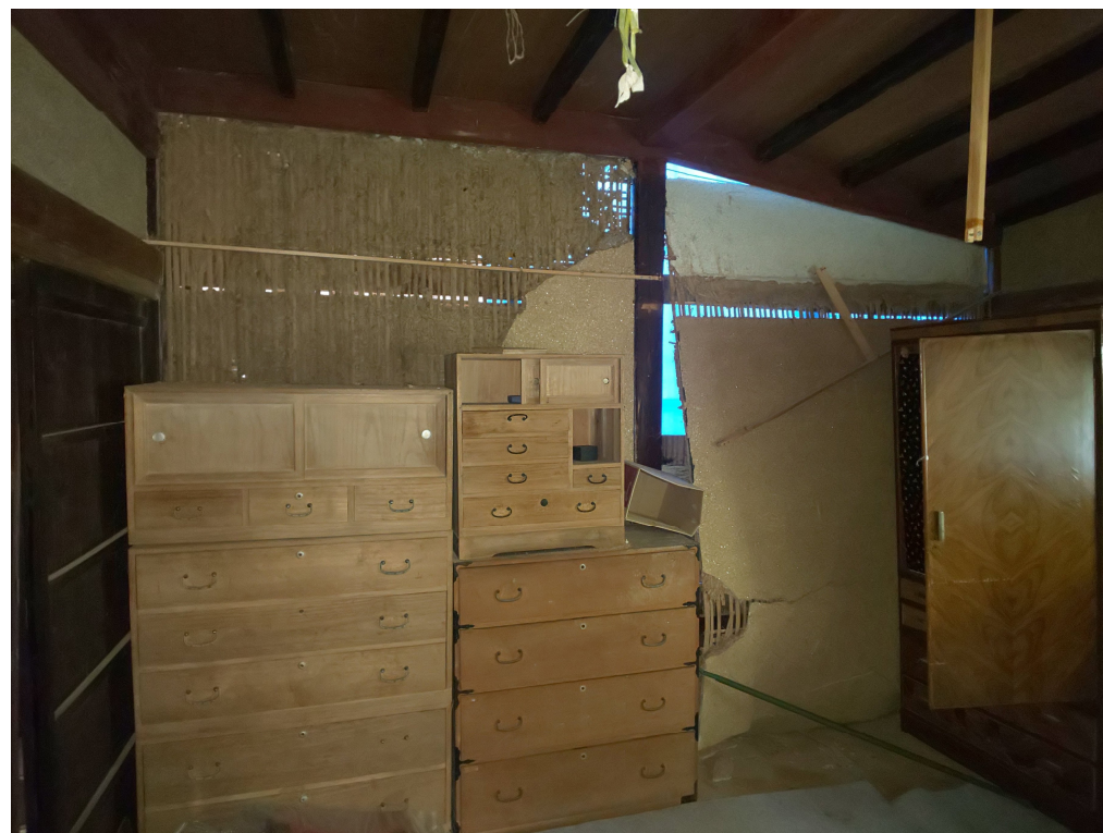
1階、2階根太受けが折れているのが分かる
