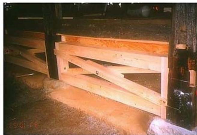
写真2 腰壁フレームタイプの補強例。床下に筋かいを設けている。仕口の欠損を考慮しても強度に問題がないことを確認している
