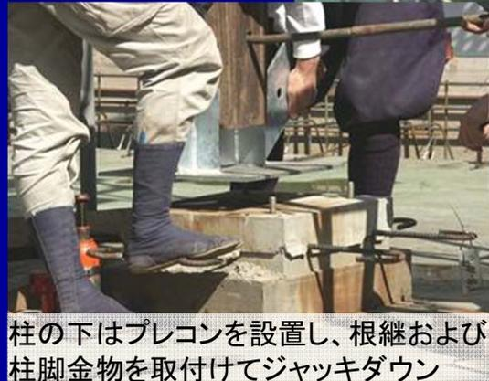
柱の下はプレコンを設置し、根継および柱脚金物を取付けてジャッキダウン
