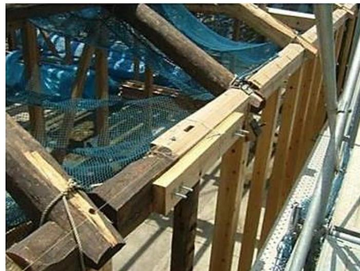
水平荷重時に引張力の作用する外周桁梁の継手を添え木補強した例
