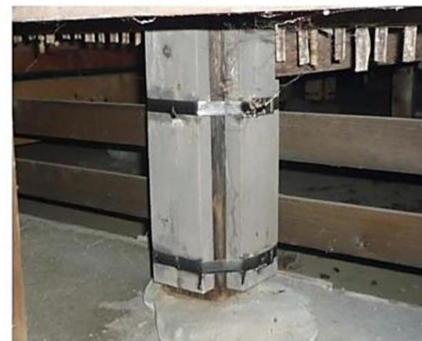
既存柱を傷めないようにするため根継部分に当て木をして、金属バンドを巻いている
